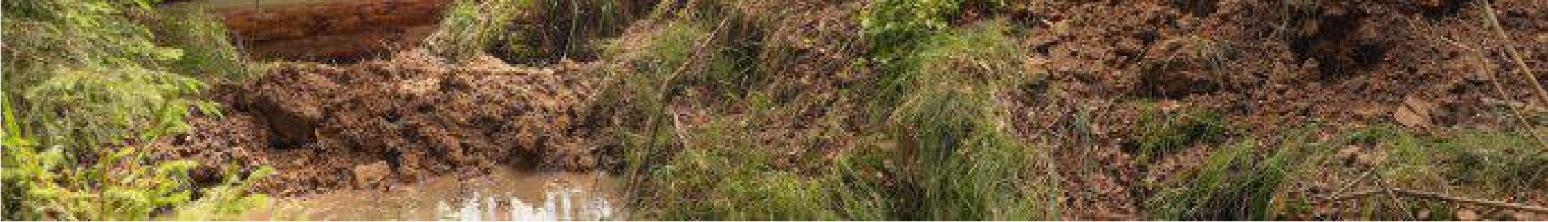
Bagr zasypává přehrazený odvodňovací kanál v prameništi na Malém Boru. Foto: NP Šumava
