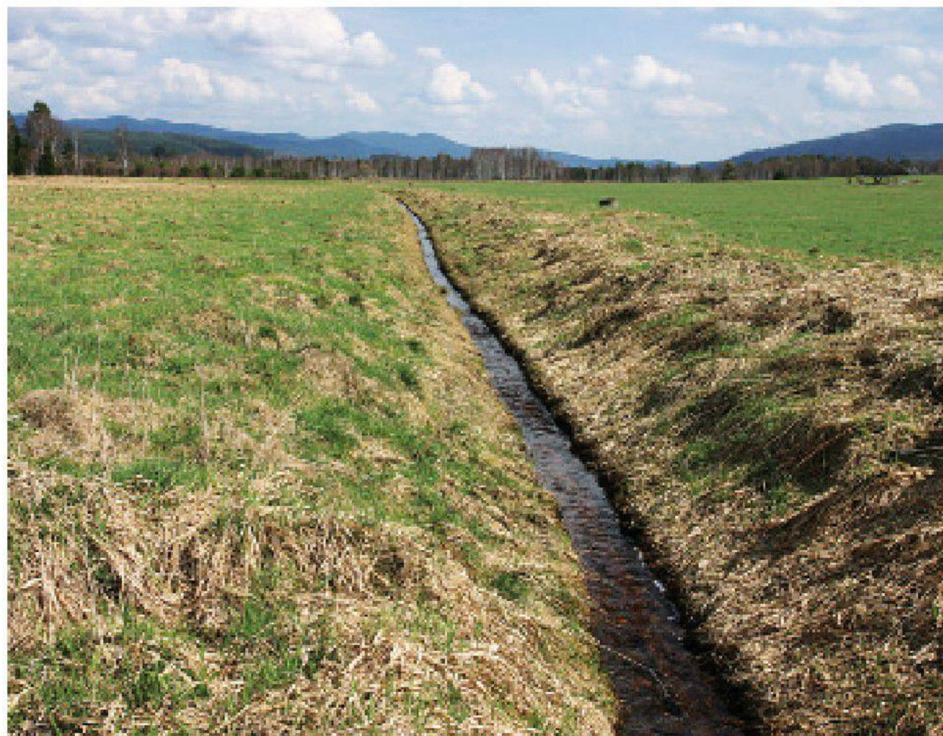
Ani podhorské úseky drobných vodních toků se nevyhnuly technickým úpravám koryta
